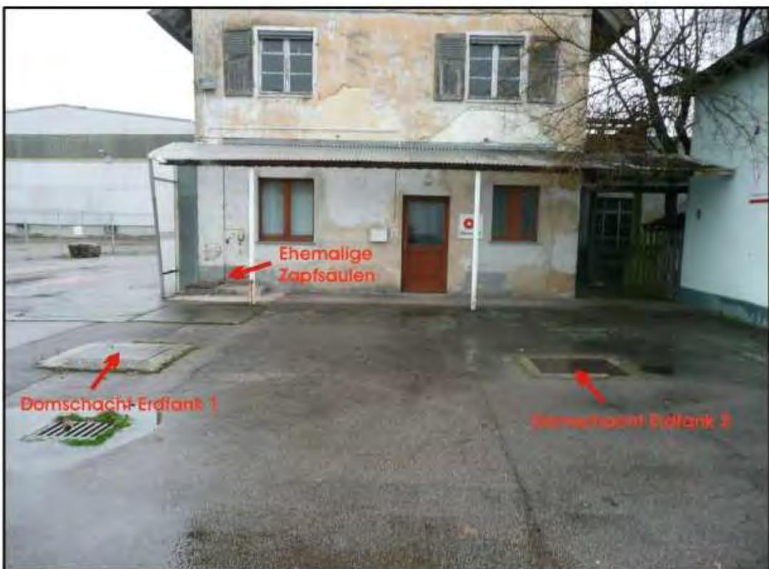
Abbildung 4.6: Lage der Erdtanks und eheml. Zapfsäulen
