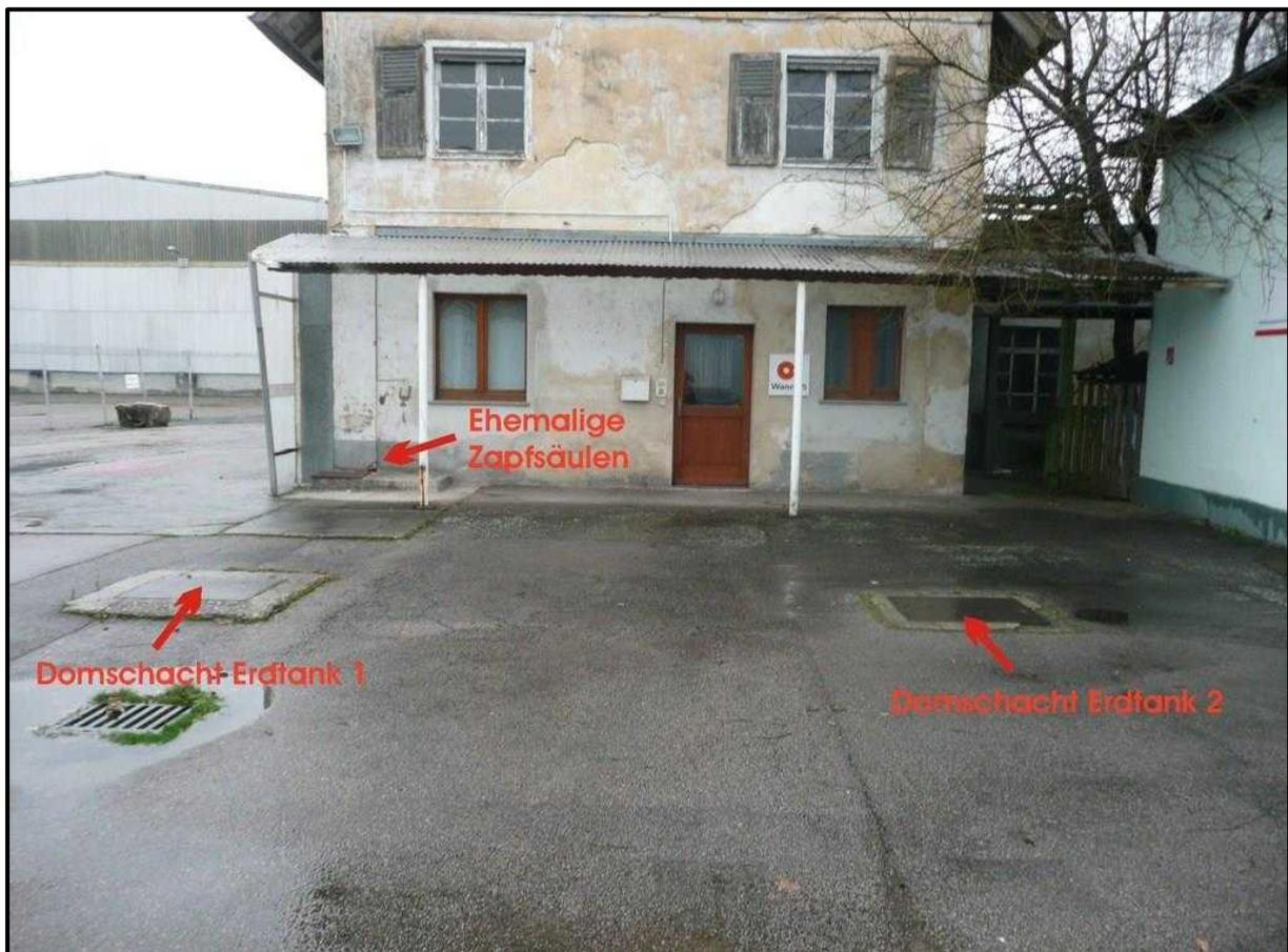
**Abb. 35: Geländebereich der Erdtanks/zugeordneter Zapfsäulen**
