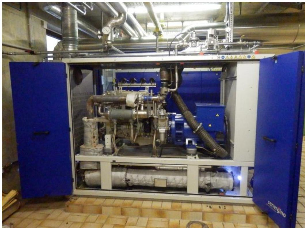
*Blockheizkraftwerk Kläranlage Achern mit einer Leistung von 2 x 50 KW*
