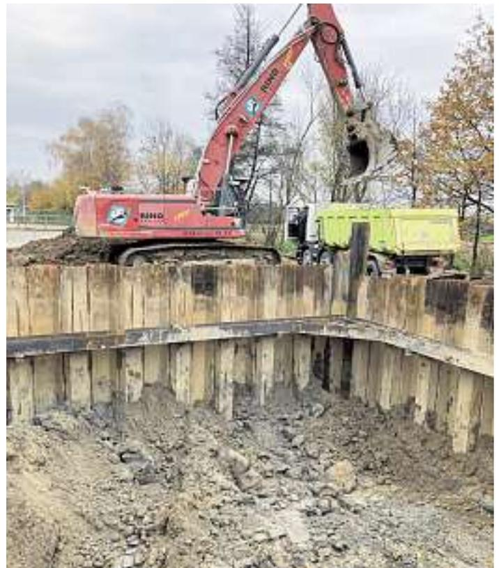
Mit den Arbeiten zum Ausheben der Baugrube für die **Tuchfilteranlage an der Kläranlage** wurde begonnen. Bis in eine Tiefe von 7,5 Meter muss die Baugrube ausgehoben werden, bevor der Unterwasserbeton zur Abdichtung eingebaut werden kann. Noch vor Weihnachten soll der Unterwasserbeton eingebracht sein.
