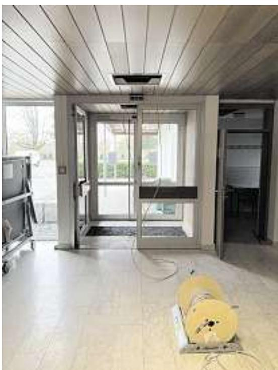
Die Sicherheitsbeleuchtung in der Mehrzweckhalle Gamshurst wird aktuell aufgerüstet. Rettungskennzeichen werden ergänzt, Stromkreis aufgetrennt und Umverdrahtungen im Verteilerschrank vorgenommen. Im Haushalt der Stadt Achern stehen hierfür 45.000 Euro zur Verfügung.
